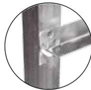
Glissières soudées par 3 points bouchonnés. largeur **15 mm**, épaisseur 1,5 mm. butées d'arrêt.
